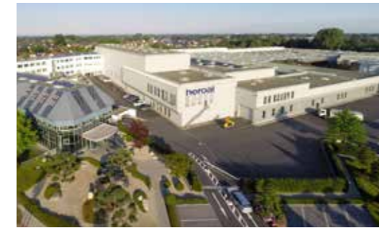
Plant I und Administration, Verl, Germany
